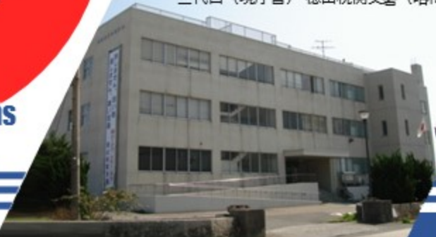
二代目 徳山税関支署（昭和34年竣工）
