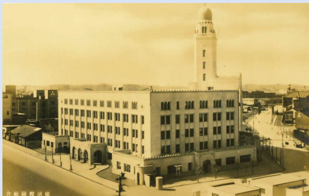
横浜税関三代目本関庁舎(1934年竣工)
