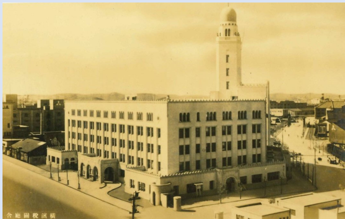
横浜税関三代目本関庁舎(1934年竣工)
