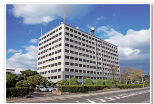
四代目(現庁舎) 門司港湾合同庁舎 (昭和54年5月完成)
