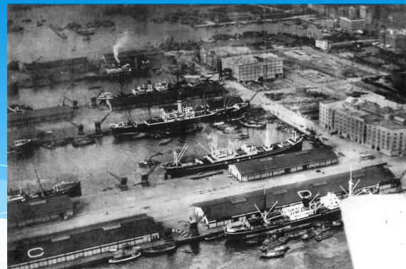
修築となった新港突堤（明治40年着工、大正10年竣工） 〔「神戸税関120年のあゆみ」より〕
