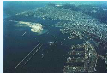
ポートアイランドの埋立て（昭和41年着工、 昭和45年にコンテナバース第1号が完成） 〔神戸市みなと総局提供〕
