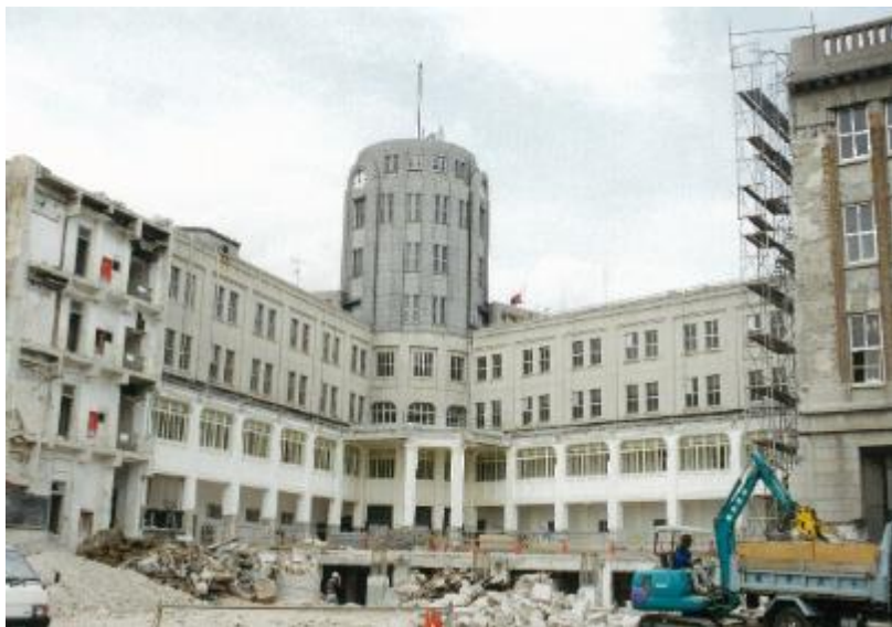
平 8.7 庁舎西側から解体が始まり、柱の姿が浮かび上がった。
