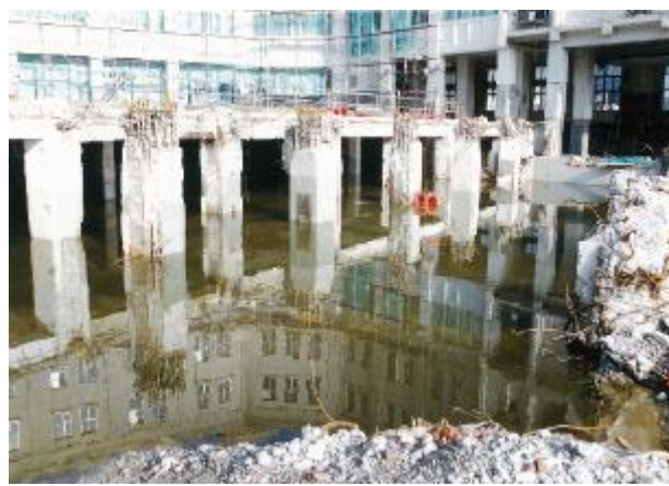
平 8.8.14 台風 12 号の高潮により敷地が 50cm 冠水し、旧館地下に設置してあった機械類が海水に浸かるなど被害が発生した。
