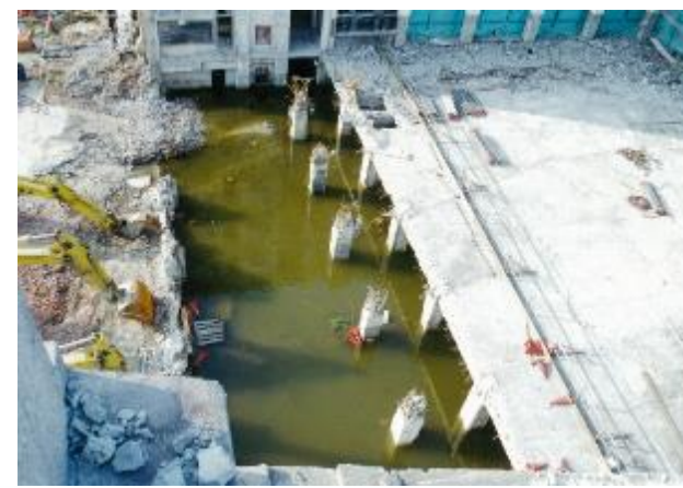
平 8.8.14 台風 12 号の高潮により敷地が 50cm 冠水し、旧館地下に設置してあった機械類が海水に浸かるなど被害が発生した。
