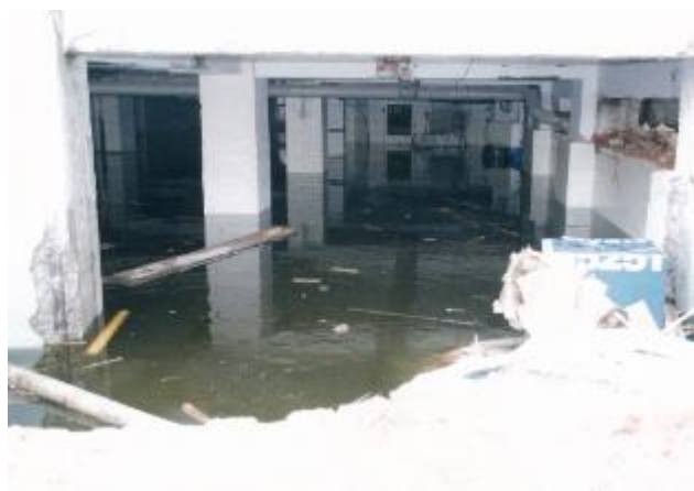
平 8.8.14 台風 12 号の高潮により敷地が 50cm 冠水し、旧館地下に設置してあった機械類が海水に浸かるなど被害が発生した。
