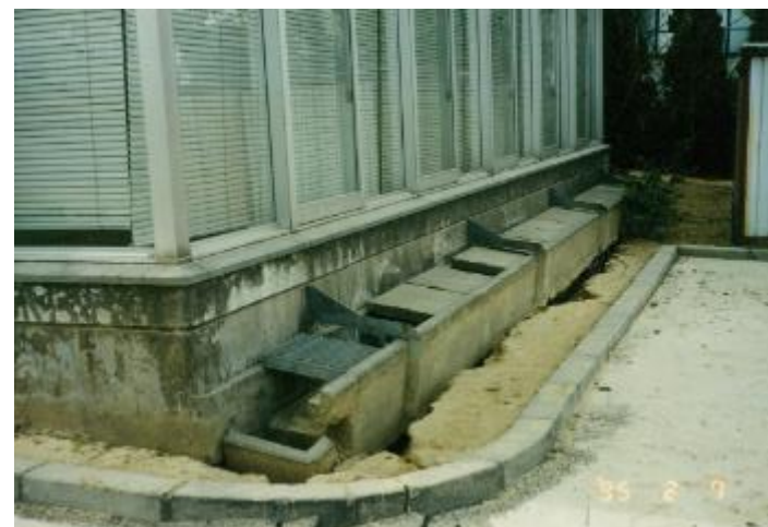
庁舎の傾斜により庁舎北側が浮いた状態になっており、基礎がむき出しになっている。
