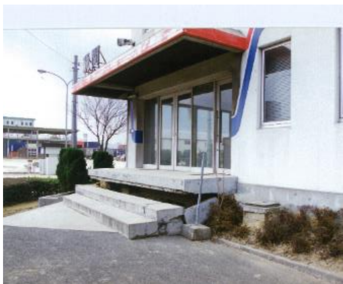
庁舎南西側が地盤沈下のため、庁舎が浮いた状態になり、約30mの段差が見られる。
