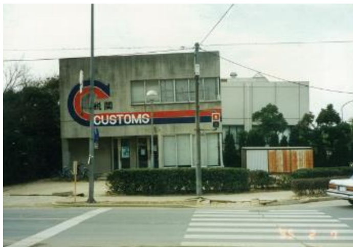
庁舎南東側が地盤沈下のため傾斜しており、周辺も地盤沈下及び液状化現象がみられる。
