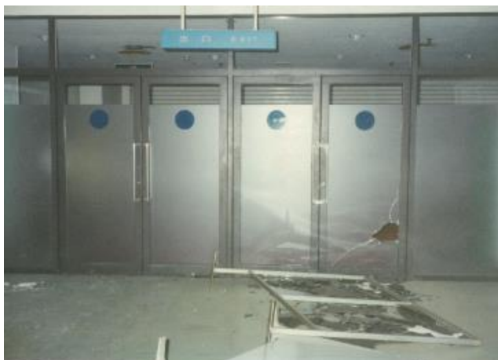
入国検査場出口のガラス扉が損傷している。
