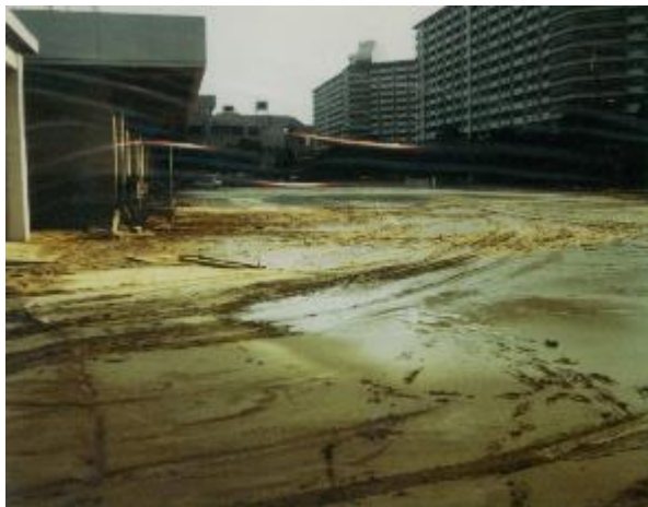
庁舎側西駐車場に液状化現象が見られる。
