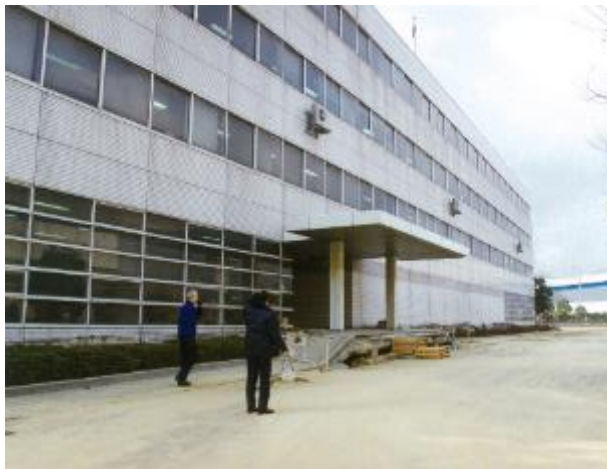
正面玄関が地盤沈下により約 20cm の段差が生じており、駐車場に液状化現象が見られる。
