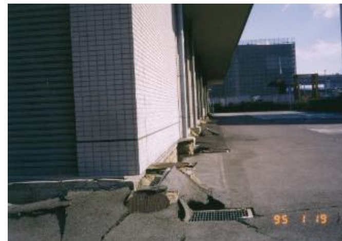
庁舎南側駐車場が地盤沈下により地割れが生じている。
