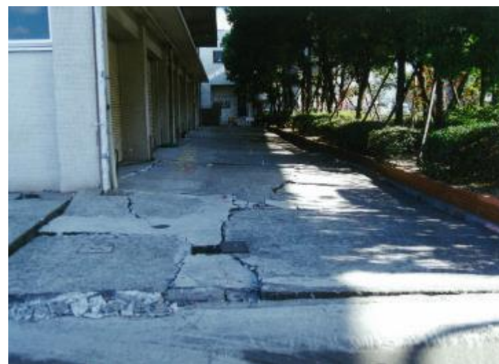
庁舎南側の敷地に亀裂が生じ、コンクリート面が破砕している。
