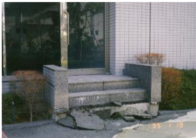
庁舎南側出入口が地盤沈下により段差が生じている。
