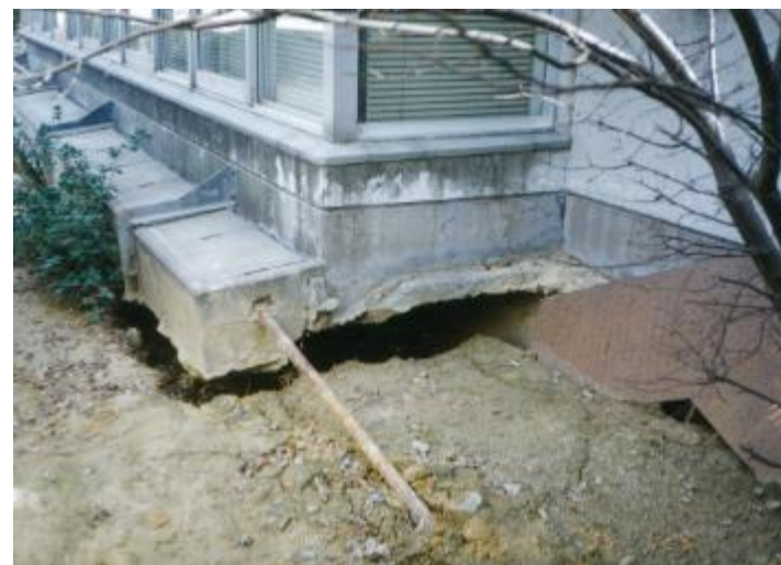
庁舎北側が地盤沈下のため浮いた状態になっており、基礎がむき出しになっている。
