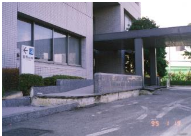
庁舎北側正面玄関のスロープが地盤沈下により使用できない状態になっている。
