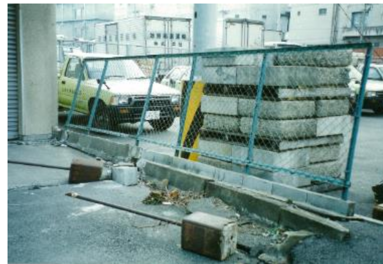
敷地が陥没、フェンス土台のコンクリート部分に亀裂が入り、フェンスが傾斜している。
