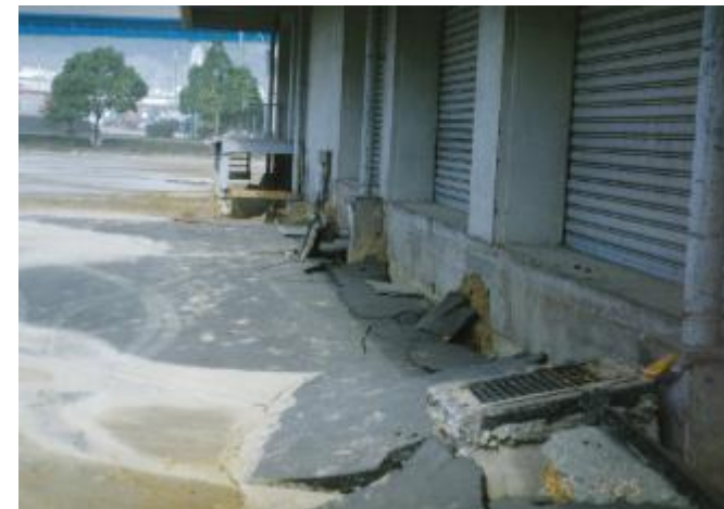
庁舎西側が地盤沈下により段差が生じている。
