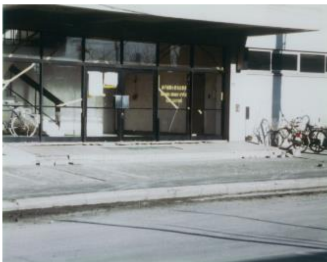
正面玄関の窓ガラスが一部破損しており、庁舎前の道路も地盤沈下により傾斜し、地割れが生じている。
