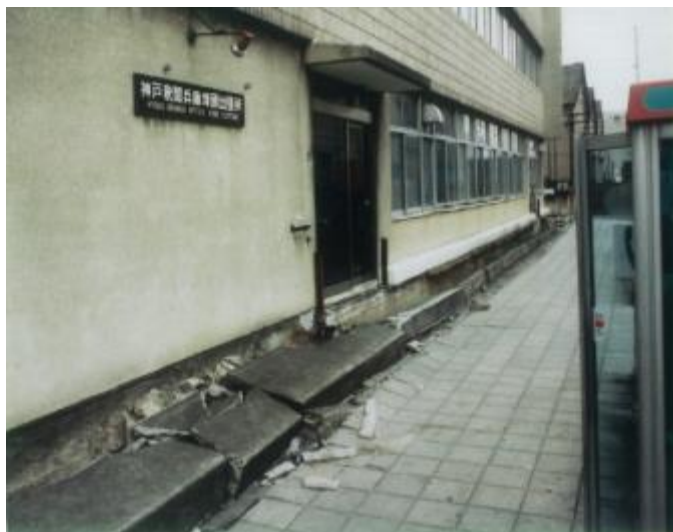
庁舎東側基礎部分が地盤沈下のためドアが歪み、自動ドアの開閉が不能になり、約 40cm の段差が生じている。
