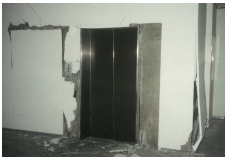
出国検査場エレベーター付近の柱が損傷しており、壁面が崩落している。
