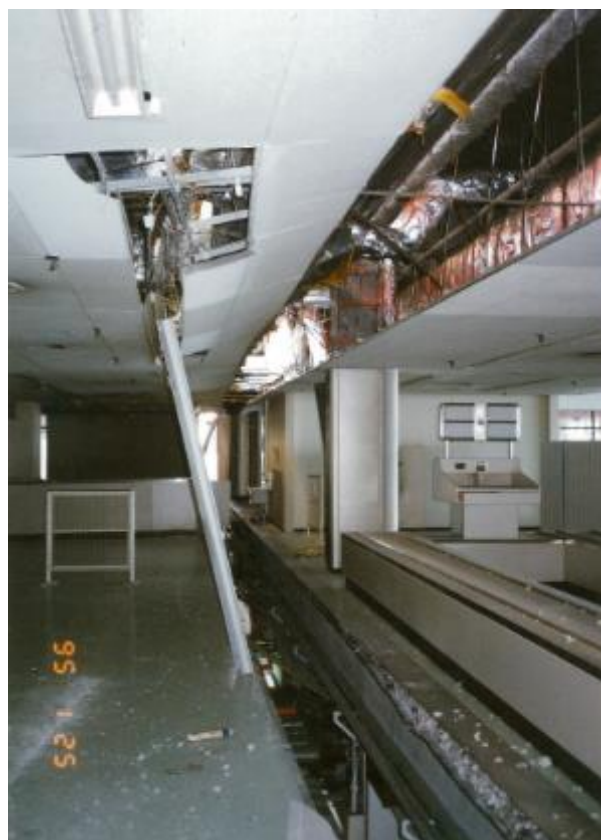
建物が分断大破して東側に傾斜している。2 階の入国検査場の床に亀裂が入り、1 階がみえ、天井から蛍光灯が垂れ下がっている。
