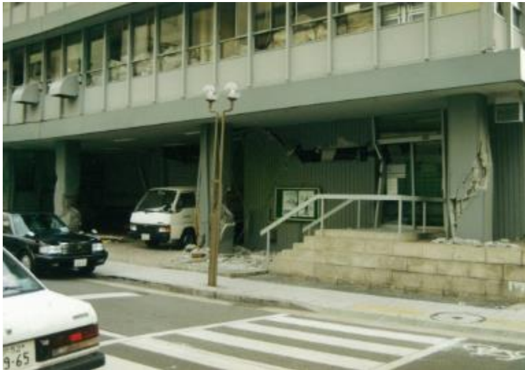
神戸外郵出張所が入居している神戸港郵便局1階東南側の柱が損壊し、倒壊寸前な状態となっている。
