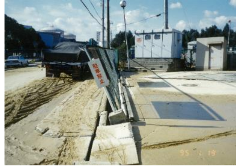
庁舎南側路上は液状化現象がひどく、敷地の境目が陥没し、フェンスが南側に傾斜している。
