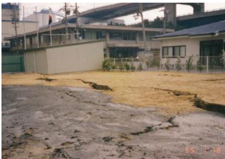
訓練用グラウンドが陥没し、液状化現象も見られる。
