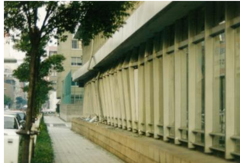
1階南側が圧縮し、庁舎が傾斜している。
