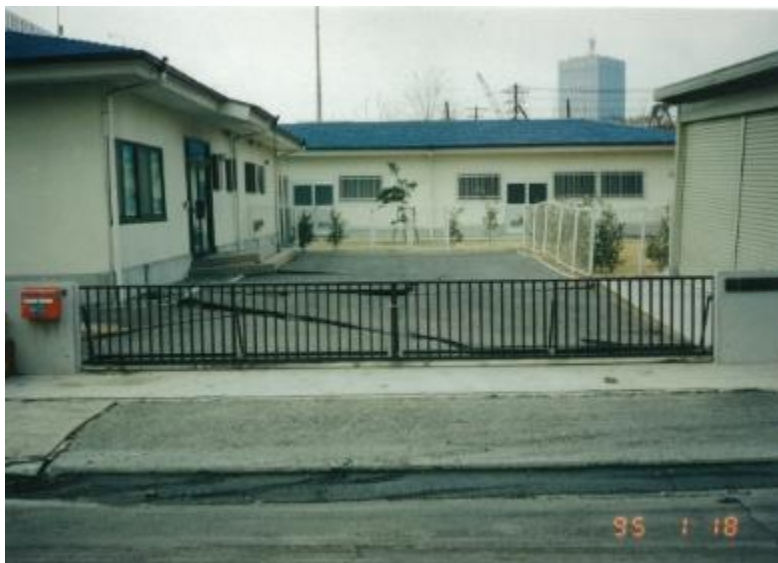
麻薬探知犬管理センター入口付近、地割れが生じ、庁舎が傾斜している。
