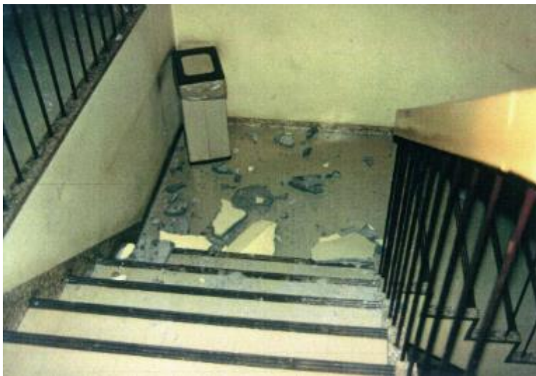
1階から2階への階段の壁面が落下している。
