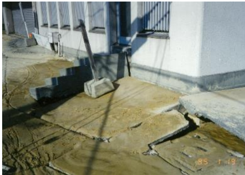
本館庁舎入口周辺が陥没、地盤沈下により亀裂が生じ、階段が傾斜している。
