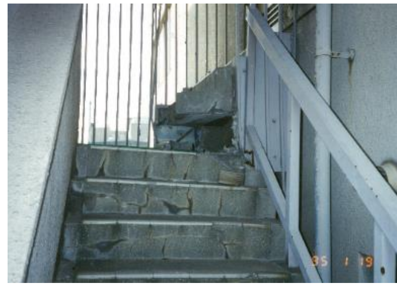
本館と分館の間の階段がくい柱の破損により建物が傾斜し、階段に隙間が生じている。
