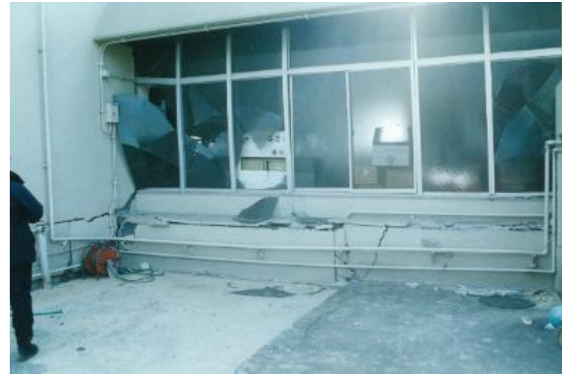
旅具検査場北側の窓ガラスが破損し、地面及び壁にも亀裂が走っている。
