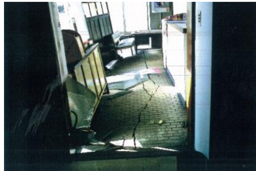
旅具検査場内の南側床部分が沈下し、床に亀裂が走り、建物が傾斜している。
