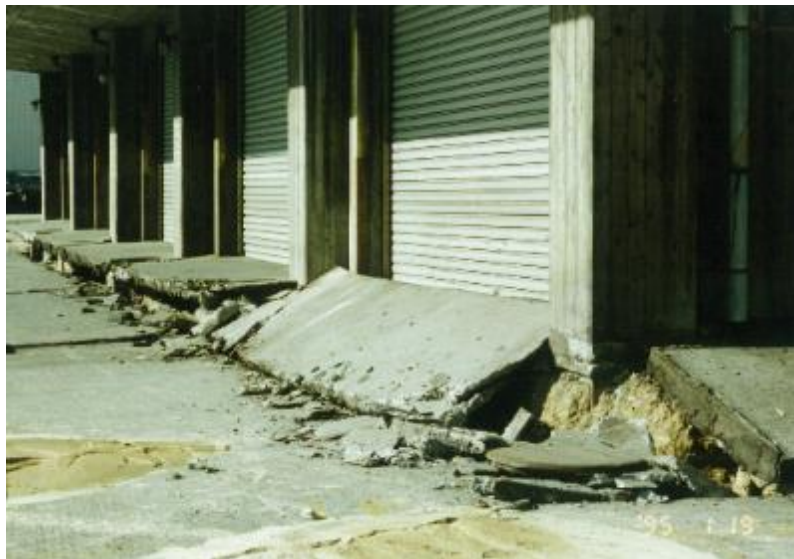
庁舎周辺が地盤沈下し、改品検査場の南側シャッター前路面が大きく陥没している。
