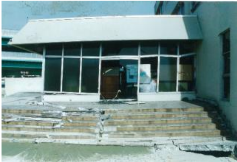
旅具検査場南側の地面が陥没、庁舎が傾斜し、事務室内は大破している。路上には液状化現象が見られる。
