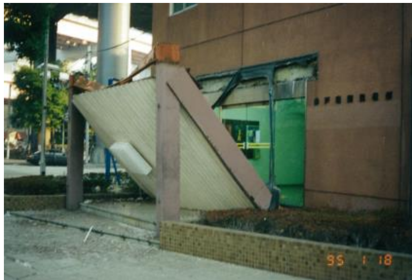
監視部庁舎の玄関底部分が脱落し大破している。
