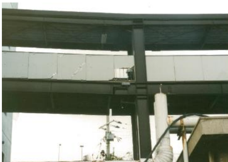
第1分館から第2分館への渡り廊下に歪みが起こり、壁も一部剥離落下し、通行できない状態になっている。
