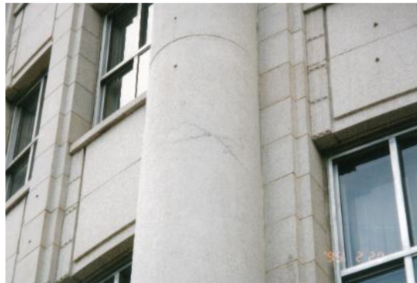
本館の正面玄関の柱に×字様の亀裂が走っている。
