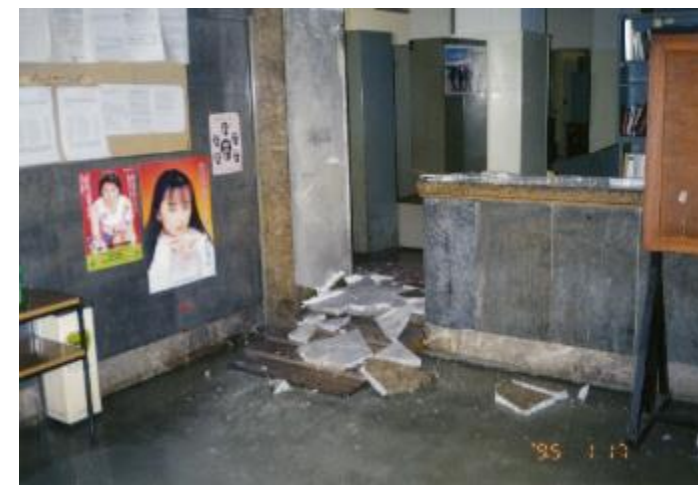
本館1階南側柱壁が崩落している。
