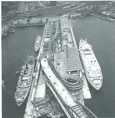
完成したポートターミナル (昭.45.4 竣工)
