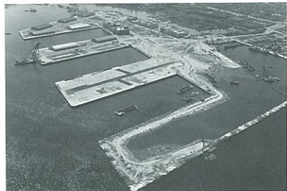
摩耶埠頭の建設 (昭.34.4 着工、昭.42.3 竣工)
