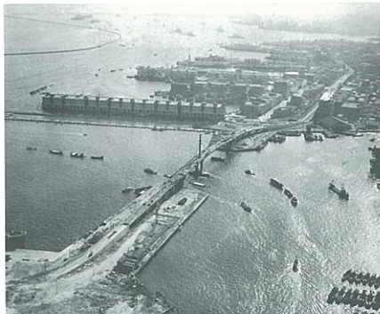
完成間近い摩耶大橋 (昭.41.6 竣工)
