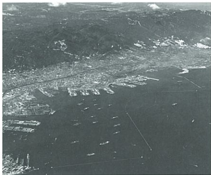
昭和35年頃の神戸港 戦後の貿易の伸長に伴って港湾施設の充実を図るため、團埠頭、新港第7・8突堤の建設が進められた。
