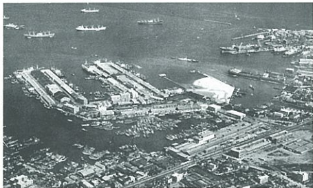
兵庫第3突堤の建設（昭.33.10 着工、昭.40.10 竣工） 石炭専用埠頭として計画されたが、取扱量の減少から輸入バナナを取り扱うことになり、昭和40年2月バナナ専用上屋が建設された。
