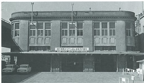
2代目メリケン庁舎（監視部庁舎）竣工（大.12.8）
