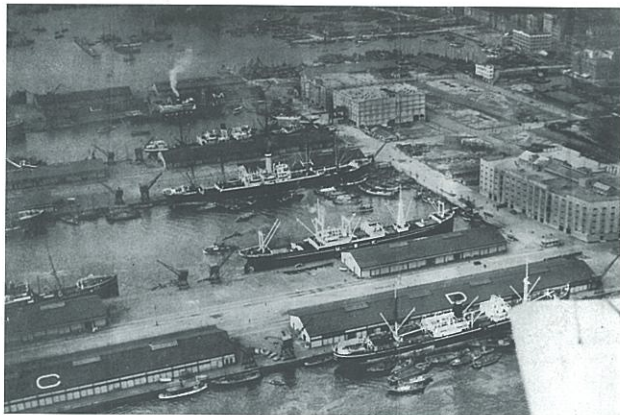
修築なった新港突堤 (明.40.9着工、大.10 竣工。写真は昭和4年頃)
