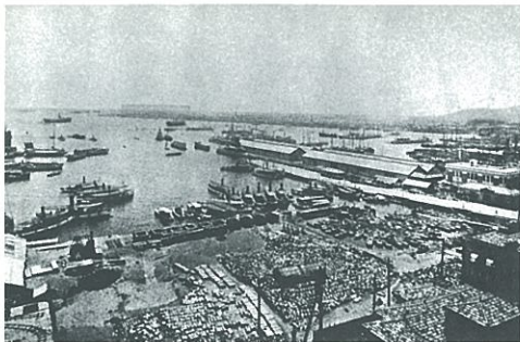
メリケン波止場と埋立工事中の海岸通地先 (太.12)
