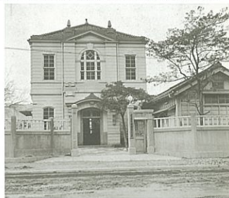
旧糸崎税関支署庁舎 (明.33.6.1 開設)
