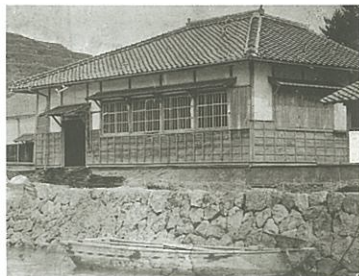
旧浜田出張所庁舎 (明.29.11.1 開設)
