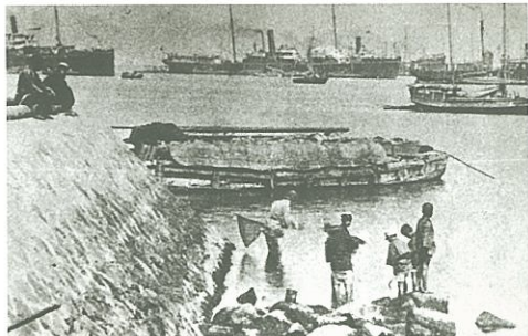
石積みの波止場
