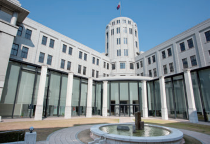
中庭から見た現庁舎
