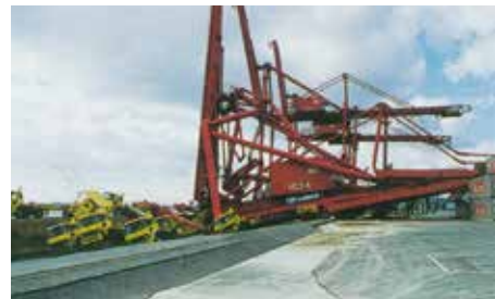
倒壊したガントリークレーン
