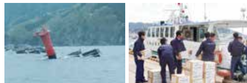
港湾の被害状況(釜石港口防波堤) 絵本・児童書を「神威」に積み込む様子
