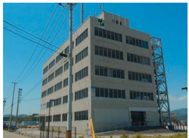
【気仙沼合同庁舎外観】
