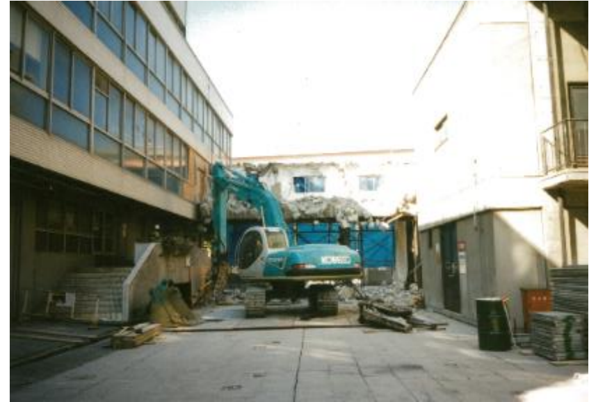
平 7.2.10 ひび割れ及び段差により通行できない状態となっていた本館庁舎と第1分館の間の渡り廊下の撤去作業を実施した。
