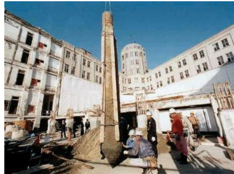
平 8.11.14 基礎地業の調査で神戸税関本館跡地の地中からペDESTAL（球根）杭が掘り出された。旧館には 919 本撃ち込まれており、本館を支えていた。
