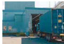
大型X線検査装置導入 (2001年)
