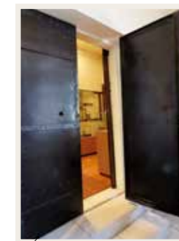
高関税品などを一時的に保管していた部屋(鉄製扉で仕切られている)
