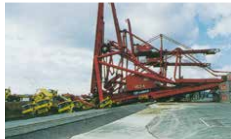
倒壊したガントリークレーン
