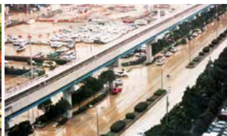
液状化したポートアイランド(写真提供:神戸市)
