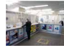
ビニールカーテンの設置
