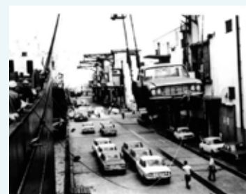
自動車の船積状況
