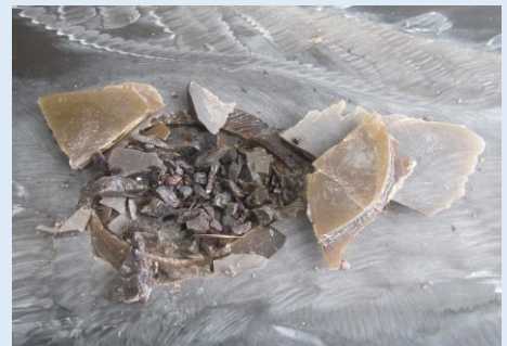
天板の解体状況
